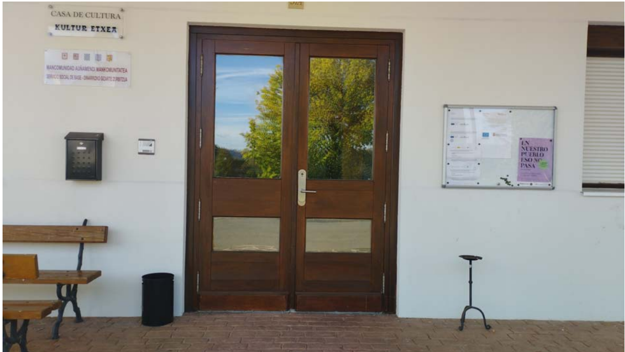
Puerta de acceso principal a edificio
