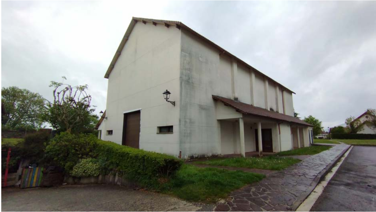
FACHADAS: LATERAL NE / TRASERA NO
